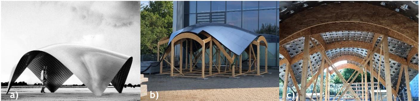
Bild 1: Impressionen des Musterbaus: Entwurf (a) und während der Montage auf einem Lehrgerüst (b und c)
