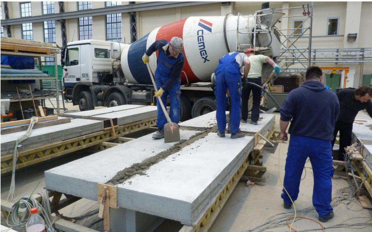
**Abb. A-8:** Ganzfertigteilträger Einbau Ortbeton
