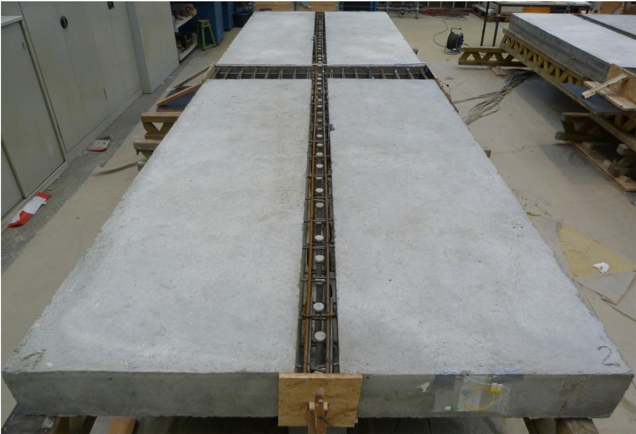
**Abb. A-7:** Ganzfertigteilträger vor Einbau Ortbeton
