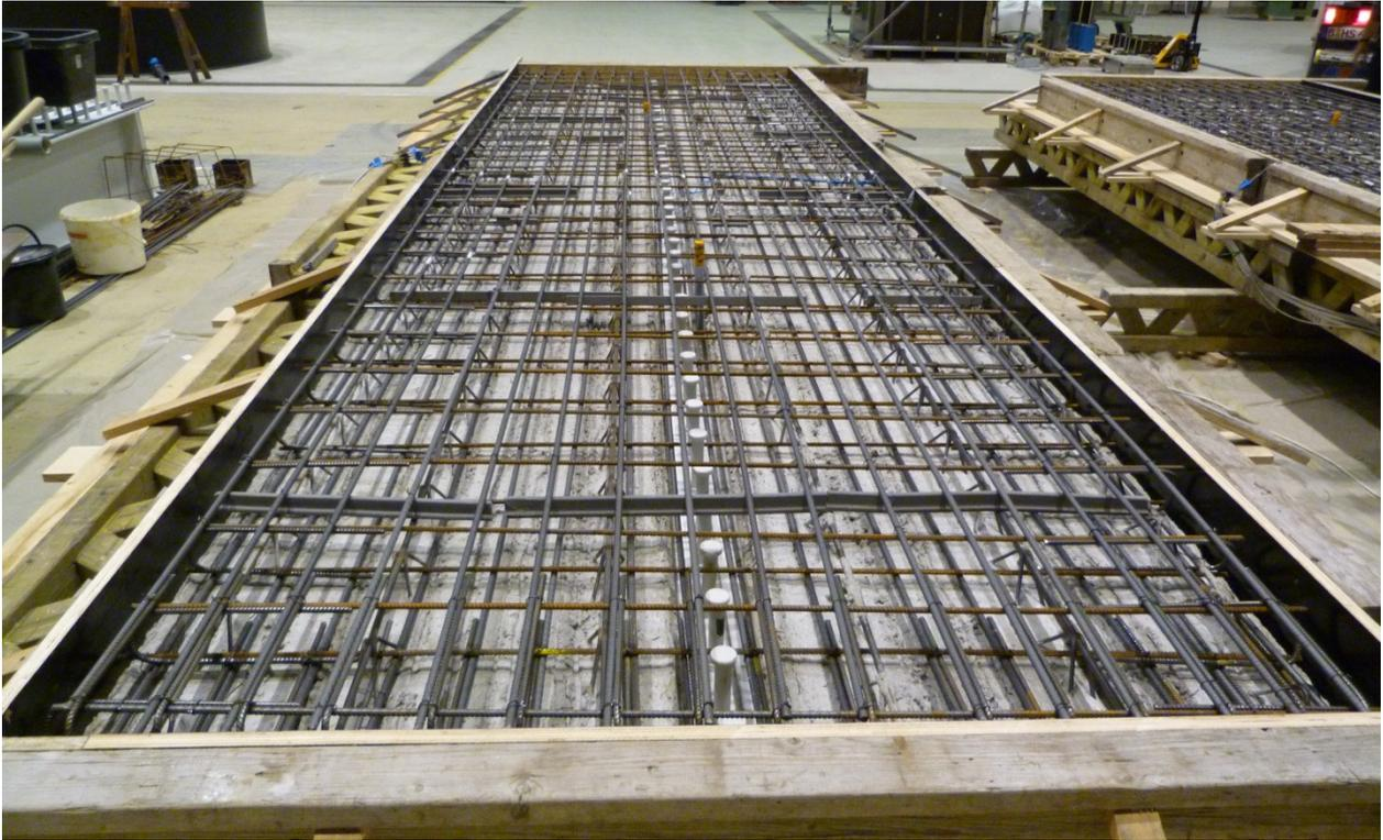
**Abb. A-3:** Teilfertigteilträger TFT d/3 vor Einbau Ortbeton
