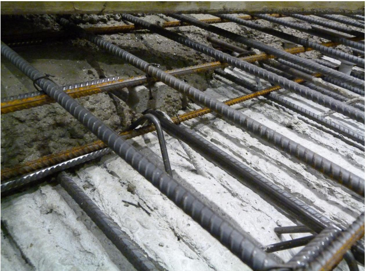
**Abb. A-4:** Teilfertigteilträger TFT d/3 Einbau Ortbeton
