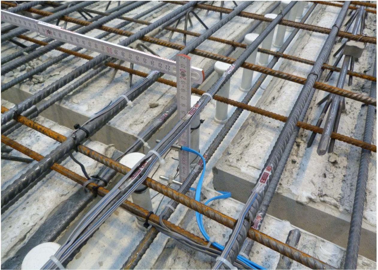
**Abb. A-5:** Fugbereich TFT-Träger mit Messtechnik
