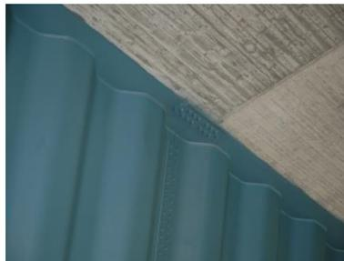
Anschluss kaltgebogenes Trapezstegblech an Trägerflansch
